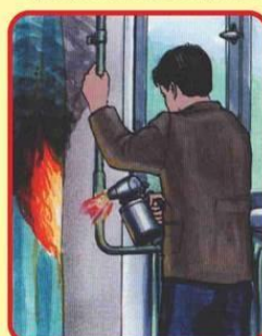
Отогревание заморозки труб паяльными лампами и факелами, нарушение правил проведения сварочных работ
